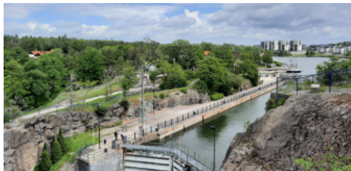
Sluserne ved Trollhättan.
