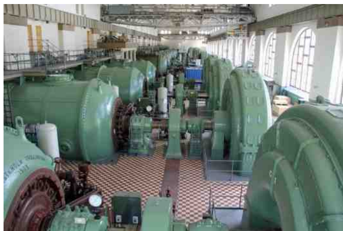
Turbinehallen ved vandkraftværket.
