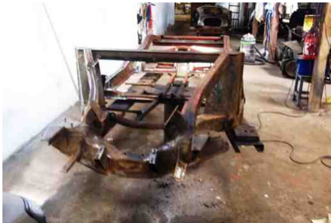
Rammen demonteret og klar til sandblæsning.
