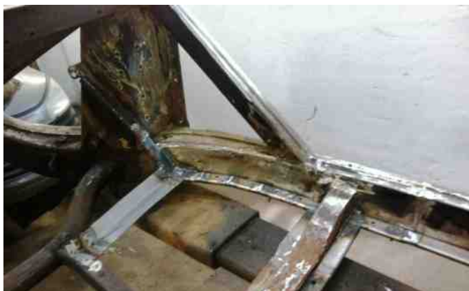
En af reparationerne på rammen.
