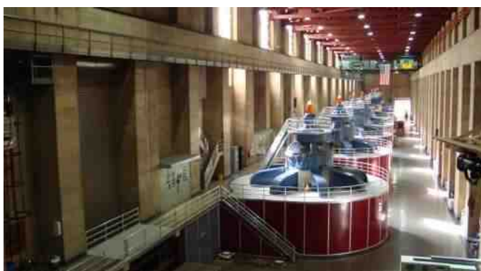
Generatorene i kraftværket.
