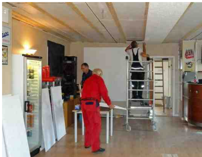
Villy, Lars, Claus og Per er netop startet på at montere anden række af Troldekt pladerne.
